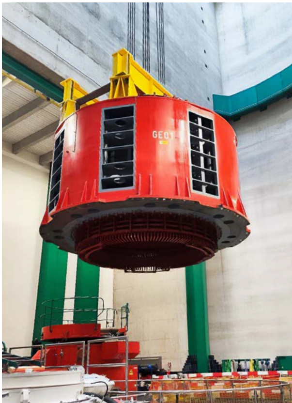
Der alte Stator wird ausgehoben ...
