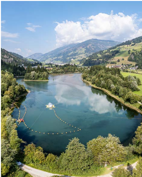
Der Speicher Tassenbach mit der Versuchsanlage
