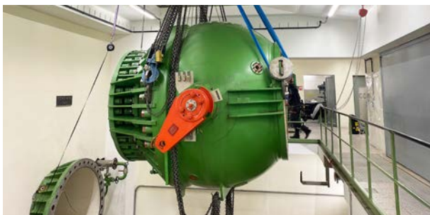
Ausheben des Kugelschiebers im Kraftwerk Imst.
