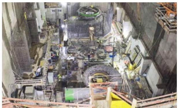
Beide Spiralen sind in der Kaverne versetzt, vorbereitet zum Einbetonieren.
