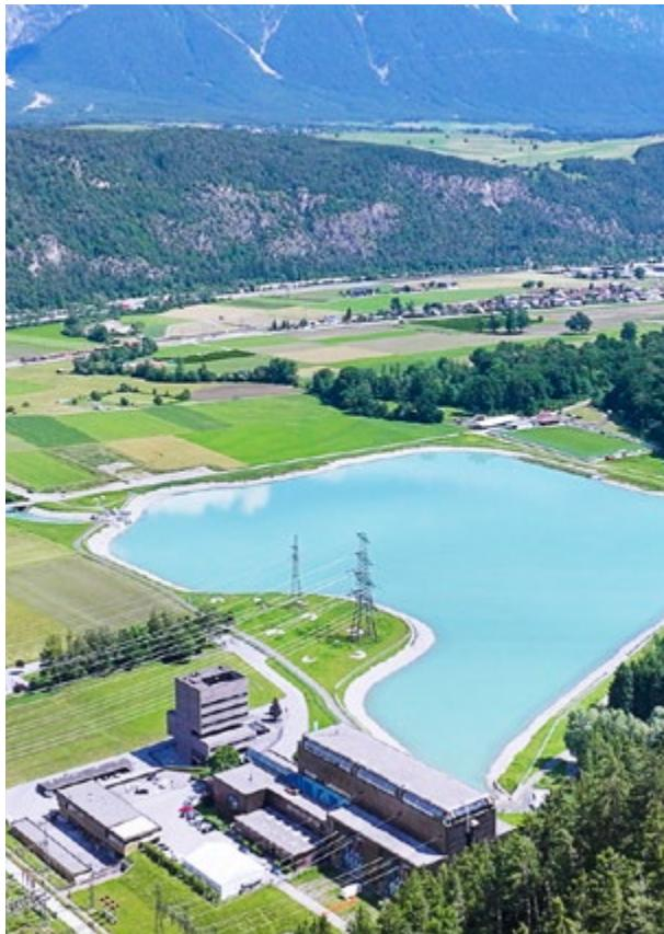
Das fertiggestellte Schwallausgleichsbecken beim Kraftwerk Silz
