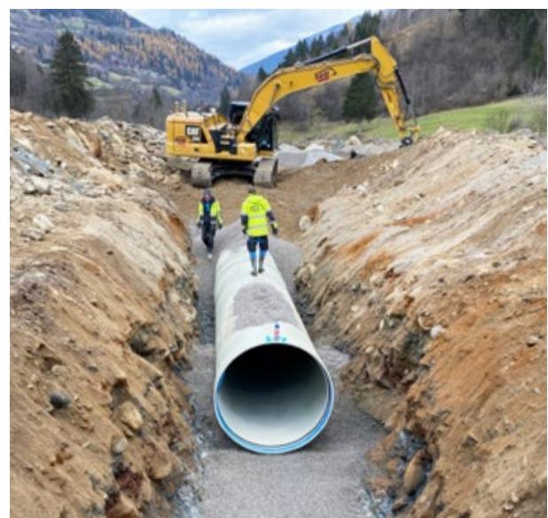
Verlegung der neuen Druckrohrleitung in Wenns
